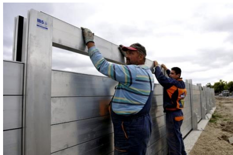
1. ábra. Mobil árvízvédelmi fal összeállítás közben Készítette: nem ismert
